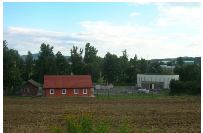
Die Eslarner Kläranlage vom Bockradweg aus gesehen.
